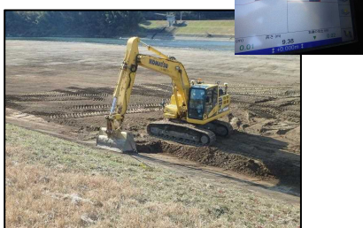
MGバックホーによる切土法面整形
