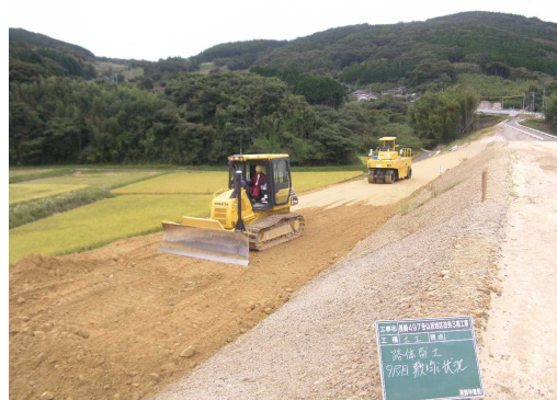
ICT建機による施工 (10月12日撮影)
