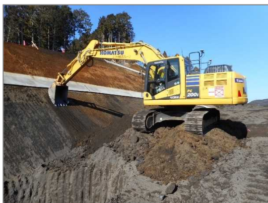
MCバックホウによる切土法面整形
