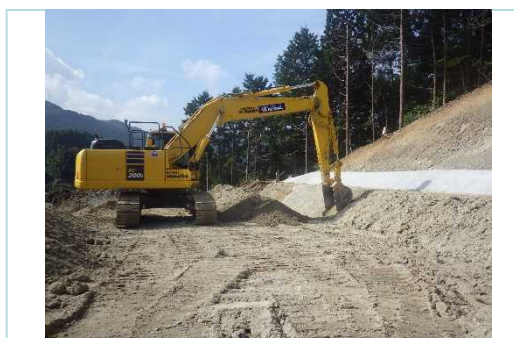
MCバックホーによる切土法面整形
