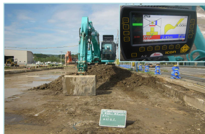
MCバックホウによる 平場整形
