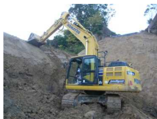
3DMCバックホーによる 掘削(土砂)モニター確認
