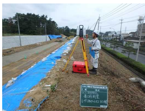
レーザースキャナーによる 起工測量
