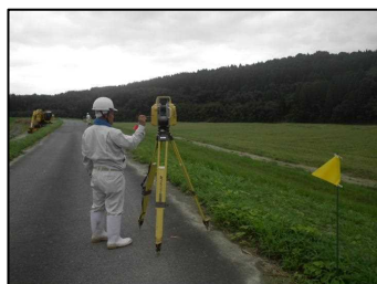
レーザースキャナーによる着工前測量
