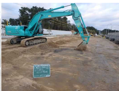
MGバックホーによる 施工基面整形
