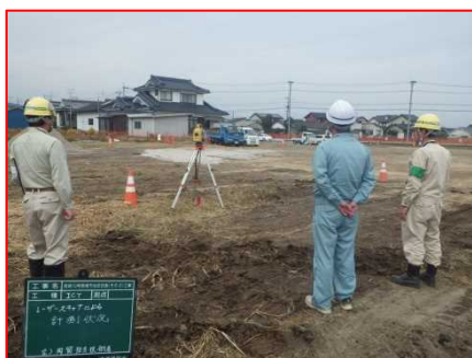
LS測量による起工測量
