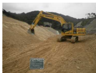
3DMCバックホーによる法面整形モニター確認
