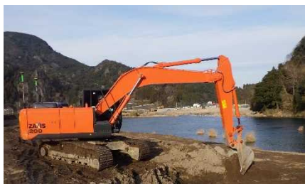
ICT建設機械施工(3次元MG)による掘削
