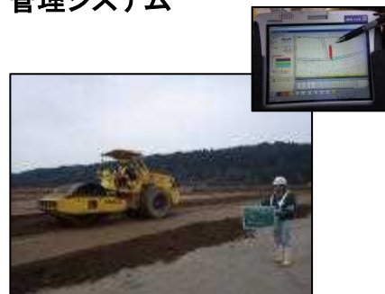
GNSSを利用した締固め管理システム
