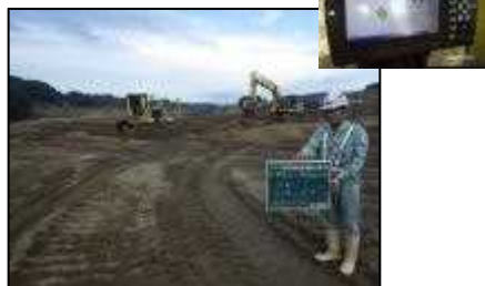
MCブルドーザによる掘削作業
