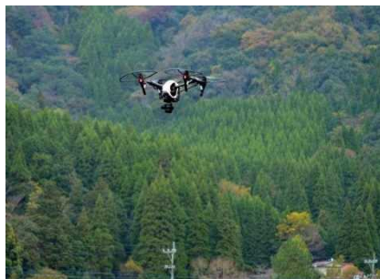
3次元起工測量UAV(ドローン)実施
