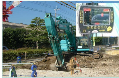
MCバックホウによる 切土法面整形
